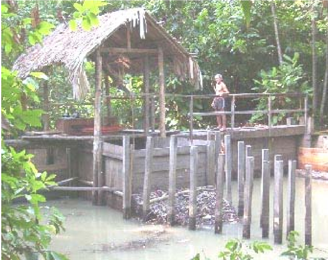
Controle do fluxo da maré com dois guia-correntes, um duto e um portão.
