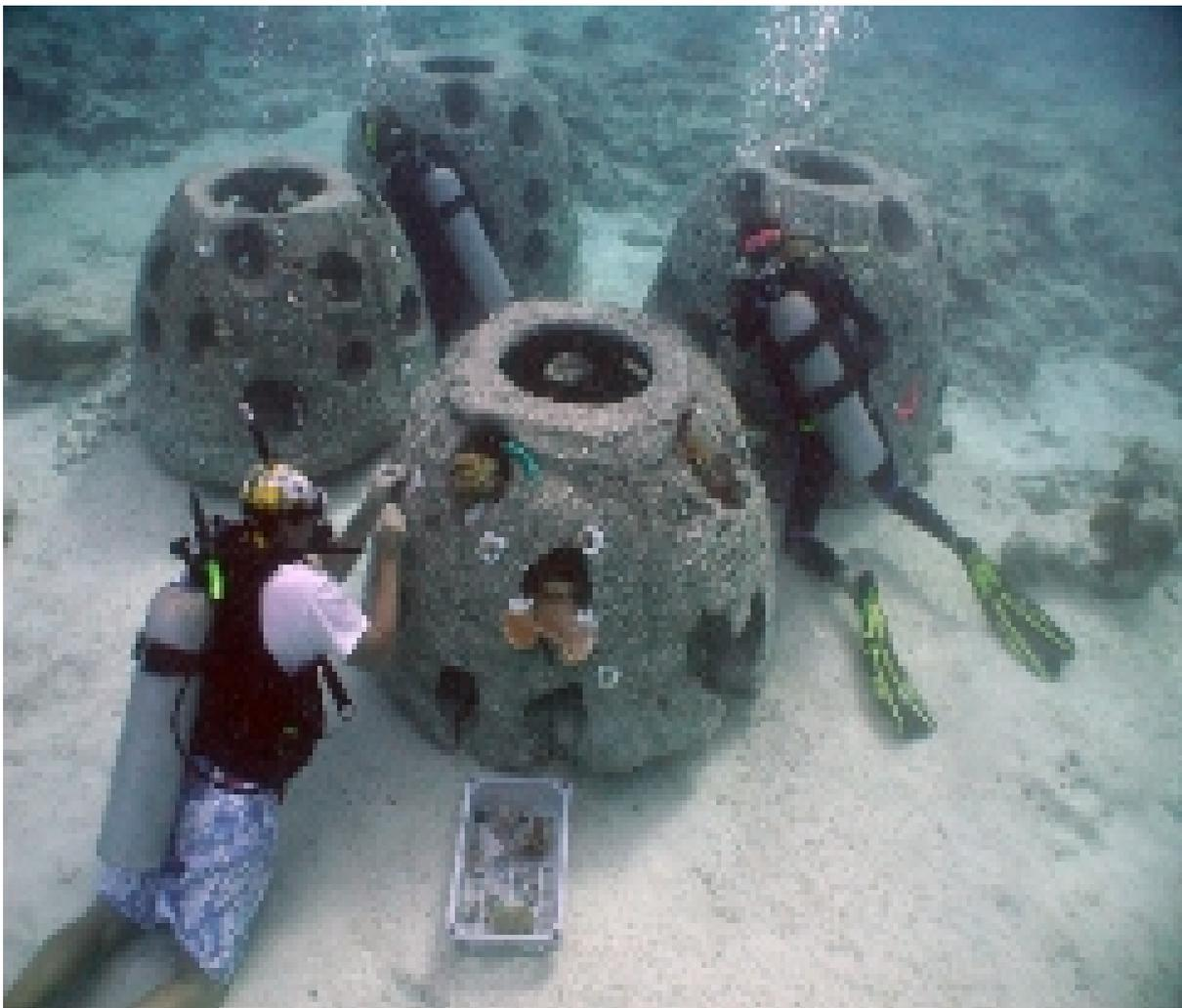
**Figure 4: Mise en place de ReefBall®.**
