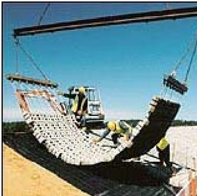
**Figure 6 a:** Mise en place d'une structure d'Armorflex®
